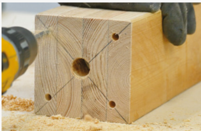
4 Bušenje otvora za vijke za drvo.
