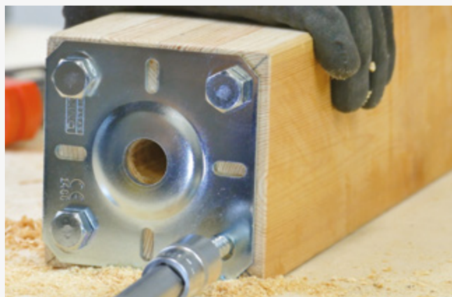
5 Pričvršćivanje gornje ploče na dno stupa.
