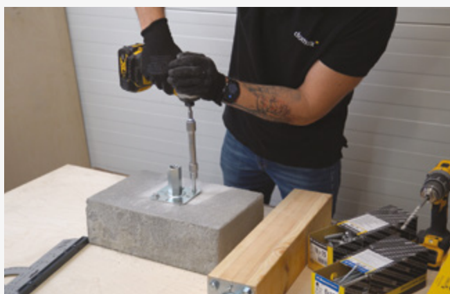
7 Pričvršćivanje donje ploče pomoću vijaka za beton.
