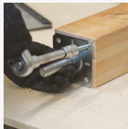
3 Pričvršćivanje gornje ploče na dno stupa.
