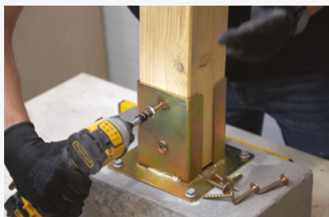
5 Pričvršćivanje vijcima za vrtnu arhitekturu.
