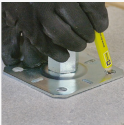
5 Prilaganje donje ploče nosača i označavanje mjesta bušenja u betonu.
