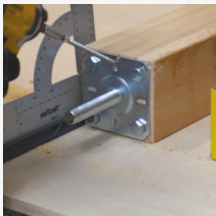
4 Dodatni otvori u obliku zrna graha za vijke s punim navojem, pričvršćivanje pod kutom od oko 30°.
