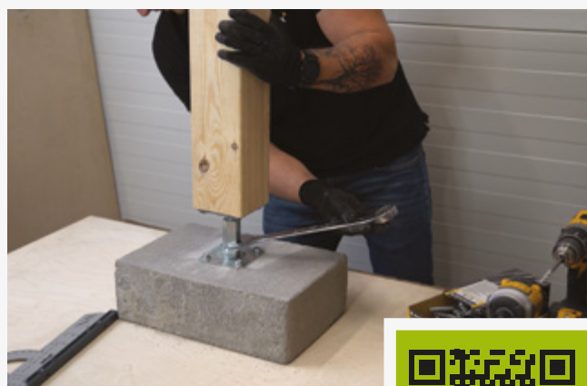
8 Podešavanje visine nalijeganja stupa od betona.
