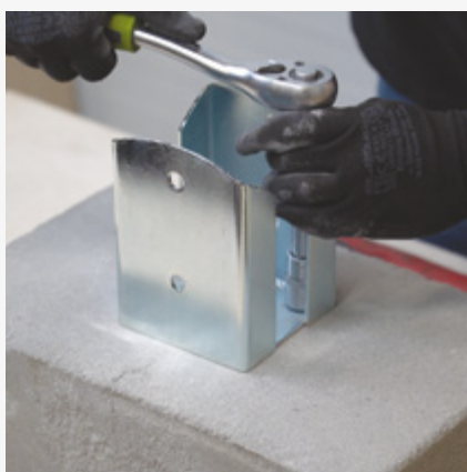
5 Pričvršćivanje nosača u beton.
