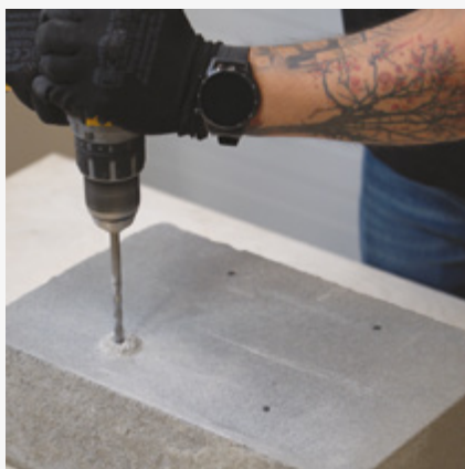
2 Bušenje otvora u betonu.
