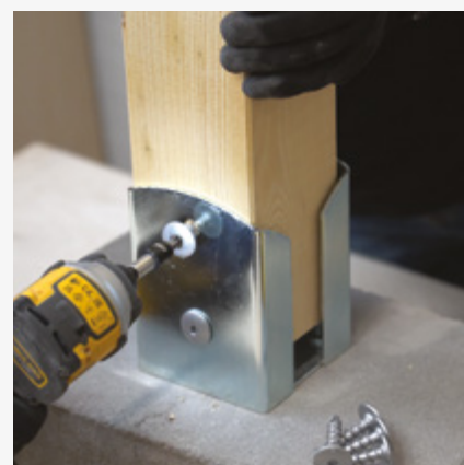
6 Postavljanje stupa u nosač i pričvršćivanje vijcima za vrtnu arhitekturu.
